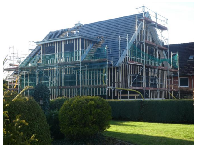
Haus Backwinkel (jetzt Kähler) Flintbeker Straße wird renoviert
